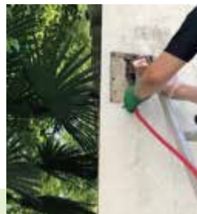
アジェンダMCを外壁より注入
